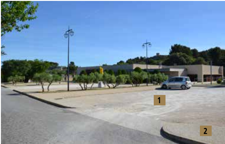
Stationnement libre, revêtement en sable stabilisé, aspect naturel
