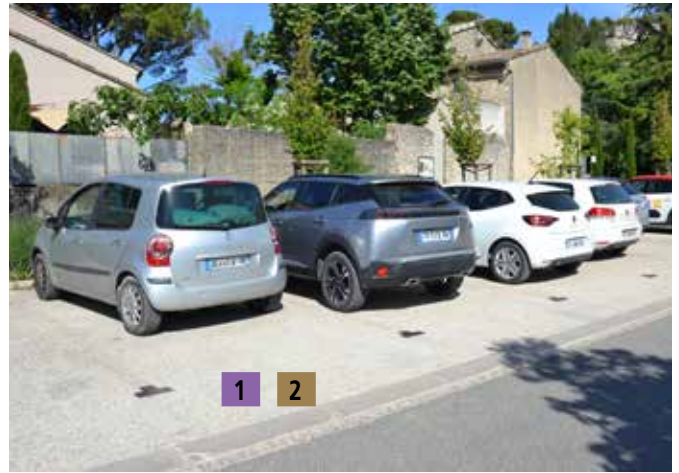
Revêtement béton couleur sable, stationnement marqué
